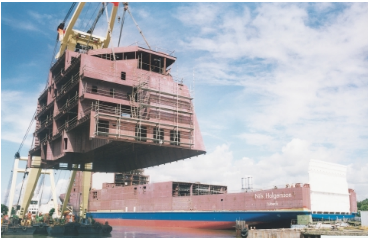
Einbau einer Decksektion in einen Fährschiffsneubau
