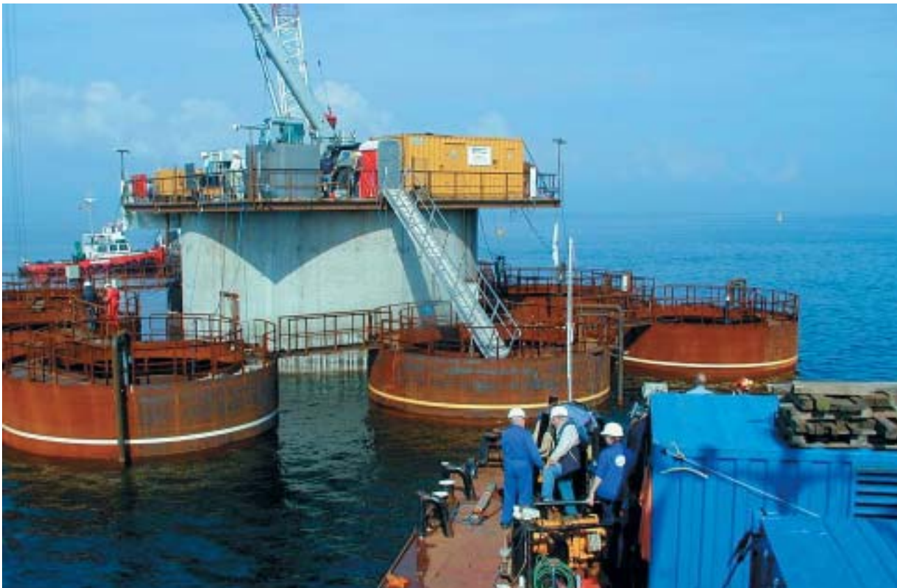
Umweltgerechter Rückbau der Offshore-Förderanlage „Schwedeneck“
