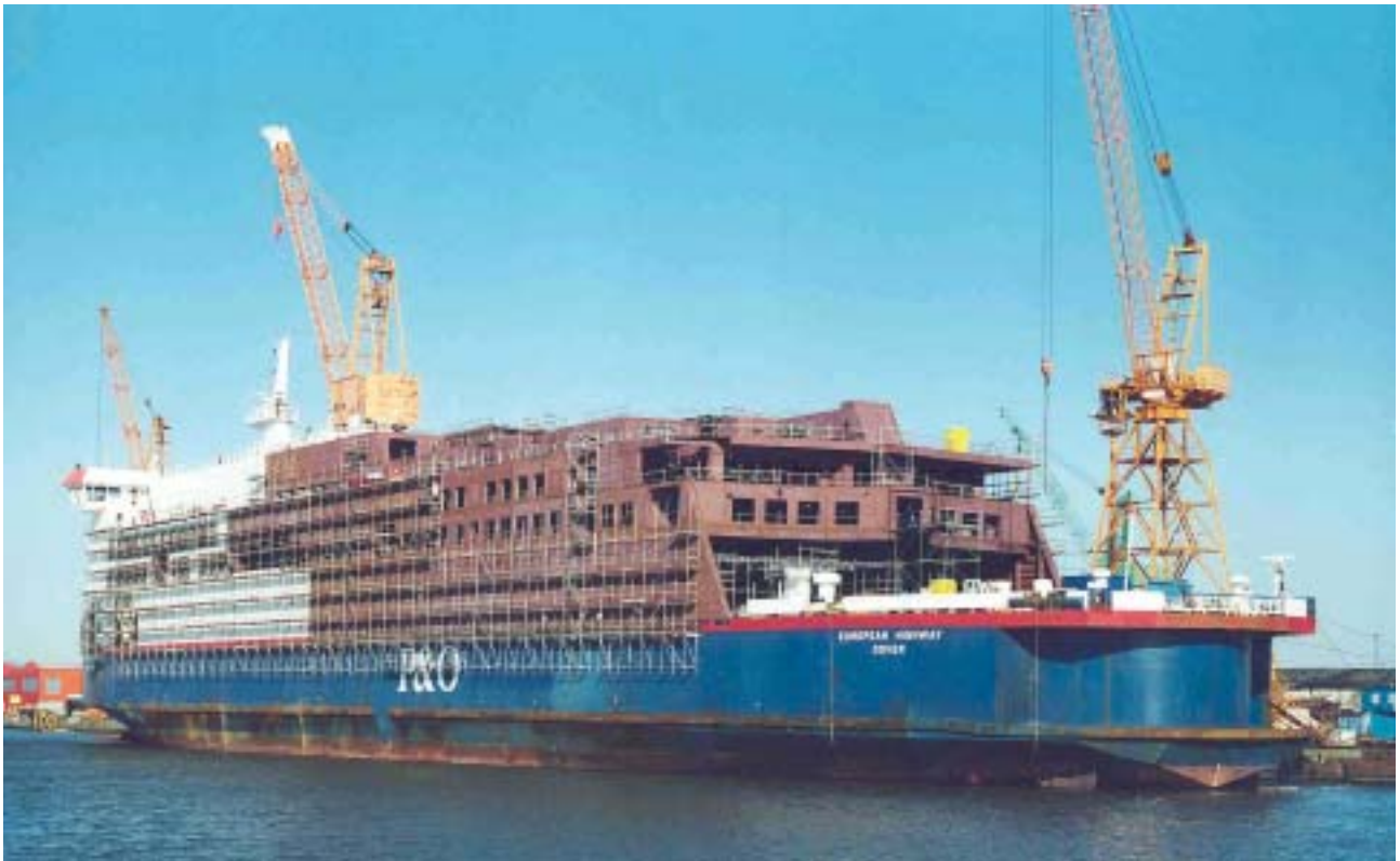
Umbau des Fährschiffes „European Highway“ für 200 Passagiere zur „Pride of Kent“ für 2.000 Passagiere
