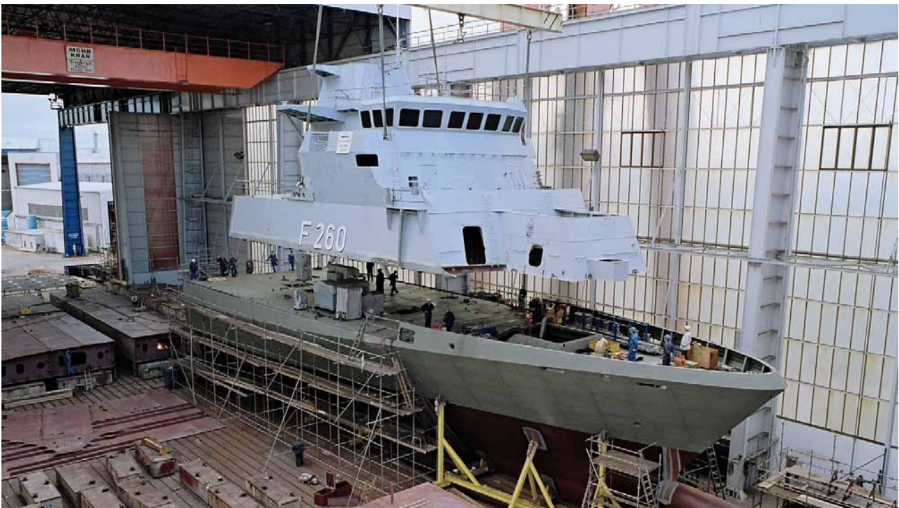
Aufsetzen der Decksaufbauten auf eine Korvette der Klasse K-130
