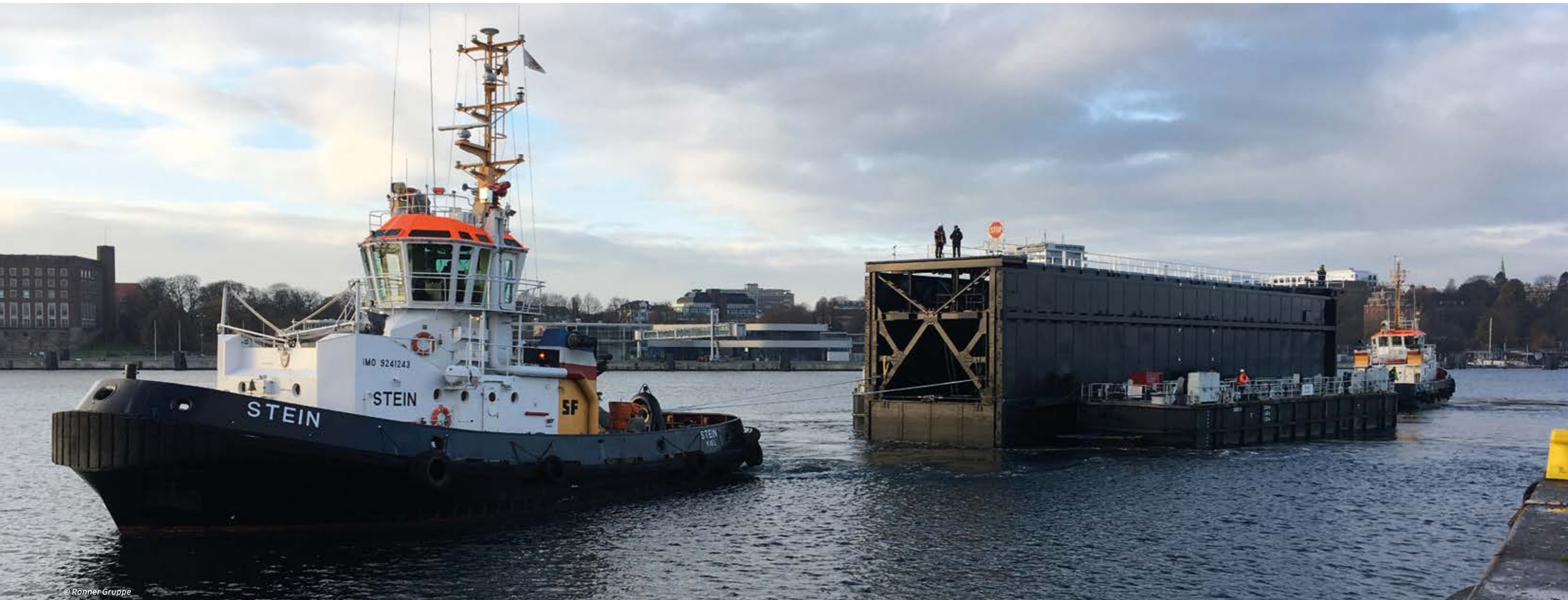
Stahlbau: Neues Schiebetor 1 zur großen Seeschleuse Kiel Holtenau
